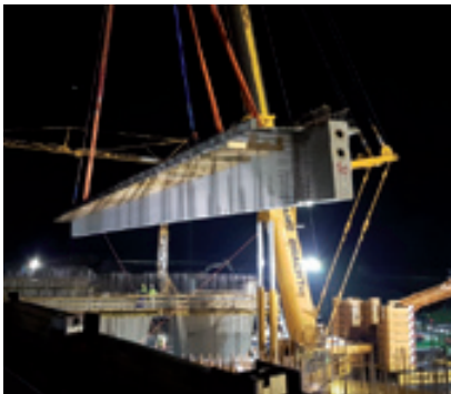
Montage der Brückenträger mit glatter Stegfläche.
