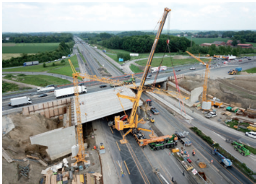
Für das Verlegen der Brückenträger wurde das Autobahnkreuz Lotte / Osnabrück lediglich für zwei Wochenenden gesperrt.
