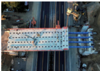
Montage der vorgefertigten Fahrbahnplatten über die A46.
