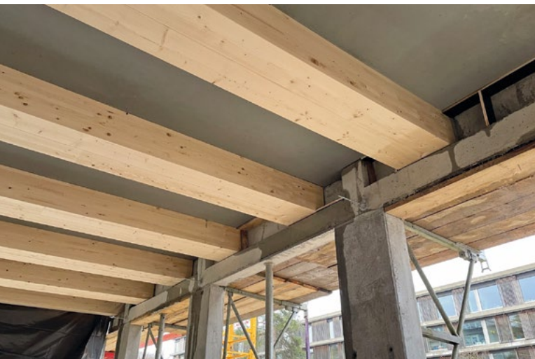
Montierte Holz-Beton-Verbunddecken auf der Baustelle.
