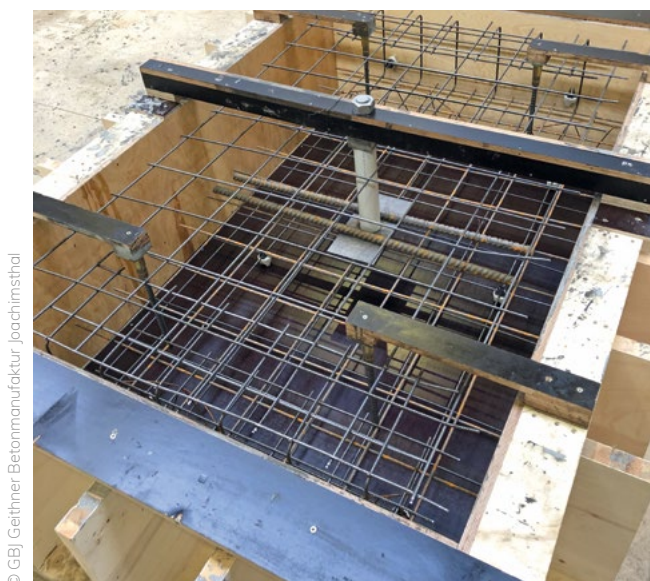
Flachstahllanker in der Schalung der Prüfplatte.
