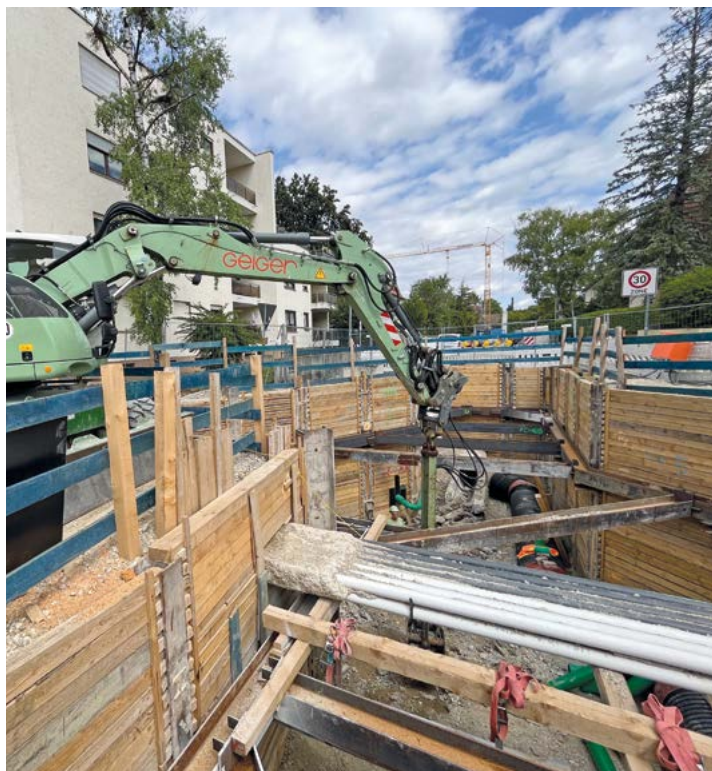
Kanalneubau im Bestand zwischen vorhandenen Ver- und Entsorgungsleitungen.
