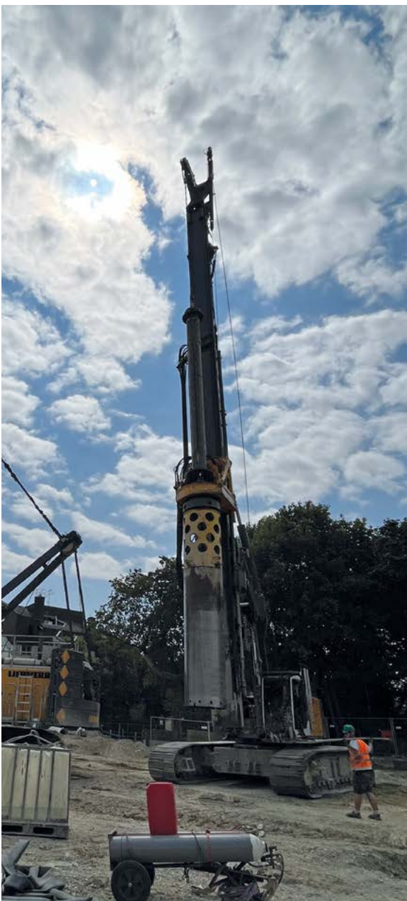
Baufeld Neubau der U5 im Münchner Westen.
