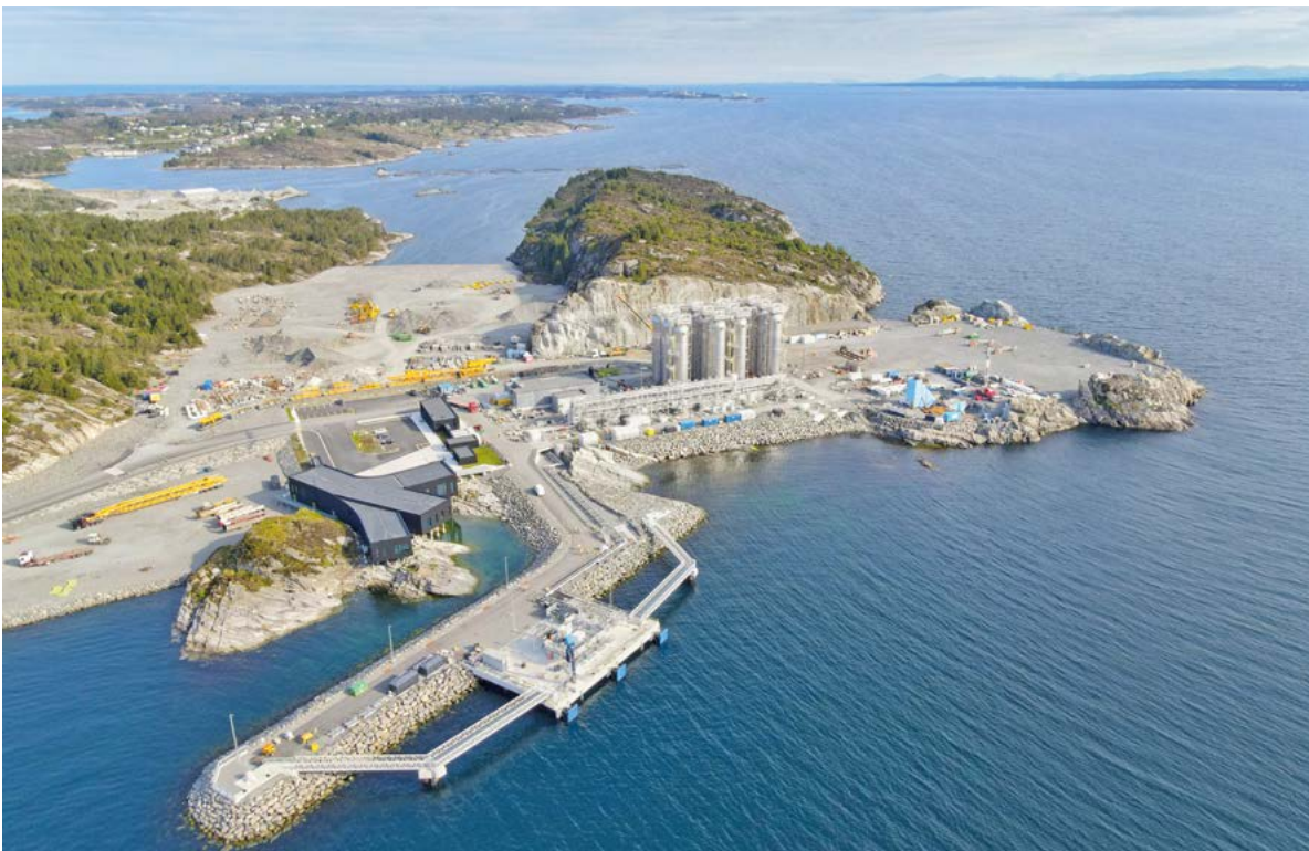
Onshore-CO 2 -Empfangsterminal vom Northern-Lights Projekt in Norwegen.
