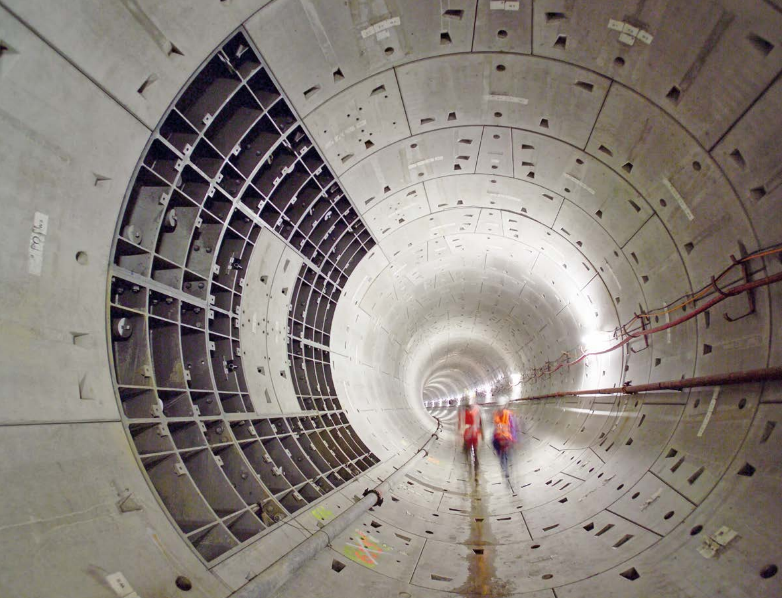
Tunnelröhre aus Tübbing. © Rekors Betonwerk GmbH & Co. KG
