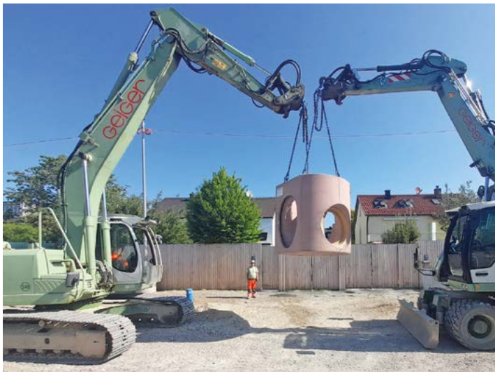
Stahlbeton-Fertigteilschacht mit Hochleistungsbeton.
