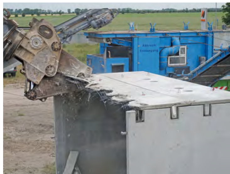
Maschineller Abbruch mit Abbruchzange (Abbruchverfahren Press-schneiden).
