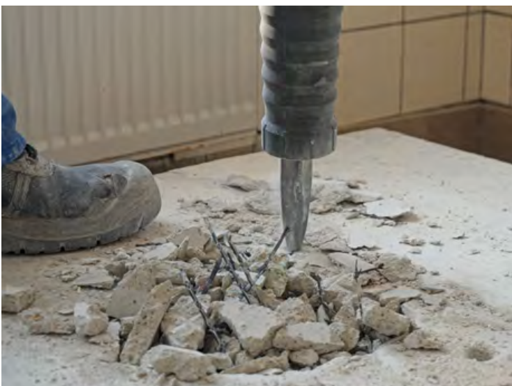
Manueller Abbruch mit dem Stemmhammer.
