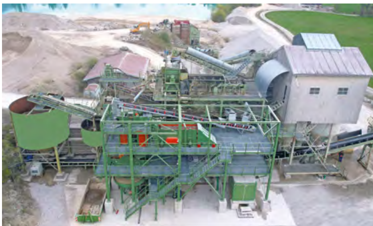
Kombination Kieswerk und Bodenaufbereitungsanlage.
