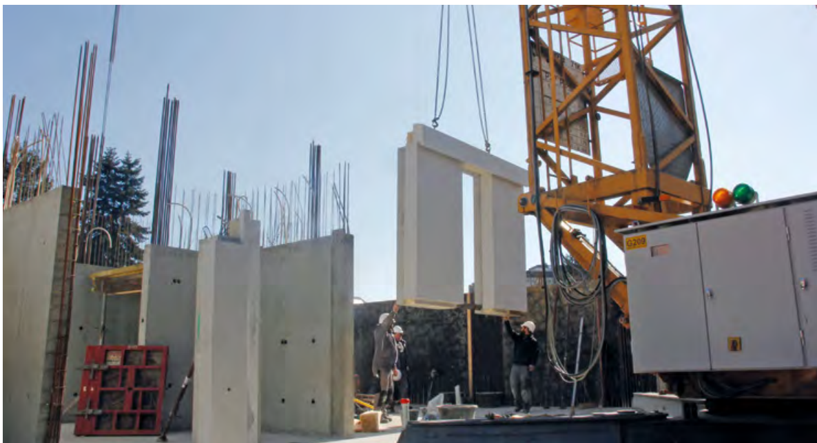
Setzen der Betonfertigteile für die Fassade.
