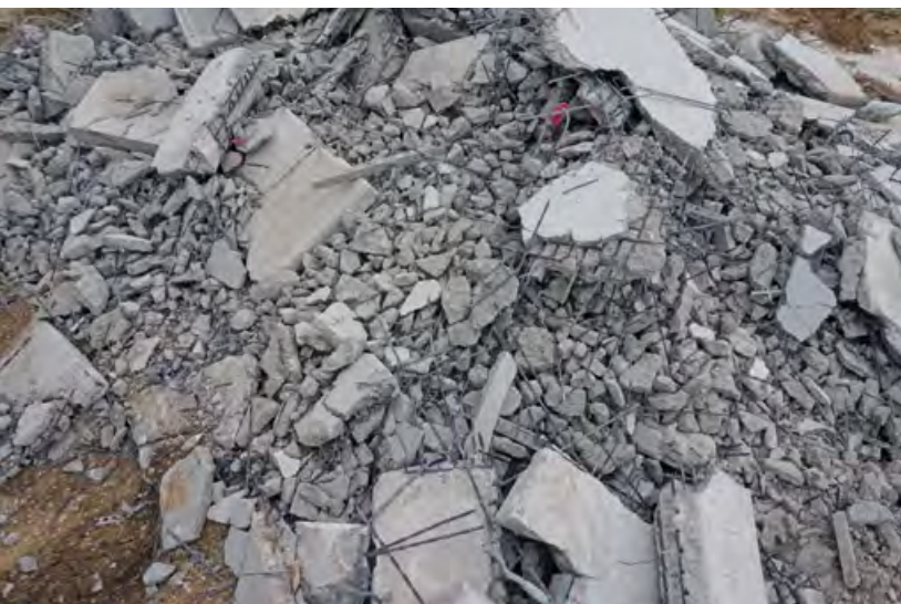
Material aus dem maschinellen Abbruch von Carbonbetonbauteilen.
