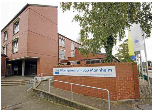
Neuer Standort für die überbetriebliche Ausbildung der Betonfertigteilbauer:innen und Werksteinhersteller:innen – das Bildungszentrum Mannheim.
