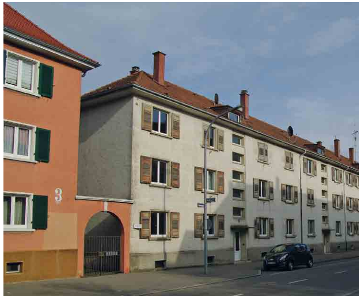
Altes Bestandsgebäude vor dem Abriss.
