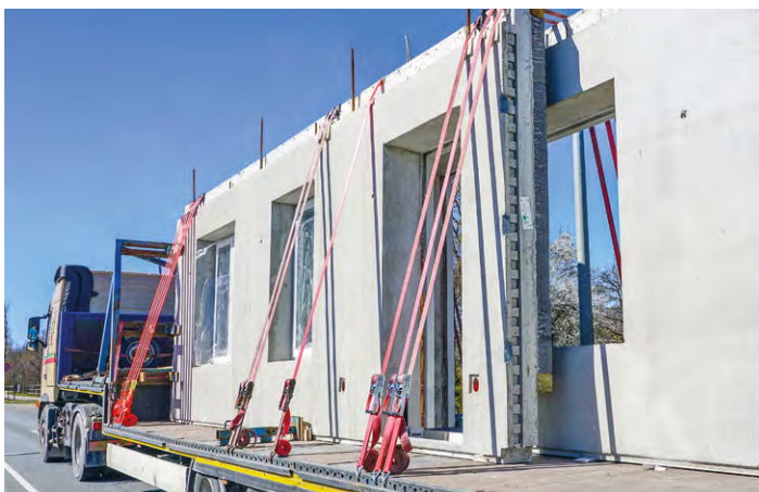
Durch die Vorfertigung lässt sich die Bauzeit reduzieren.
