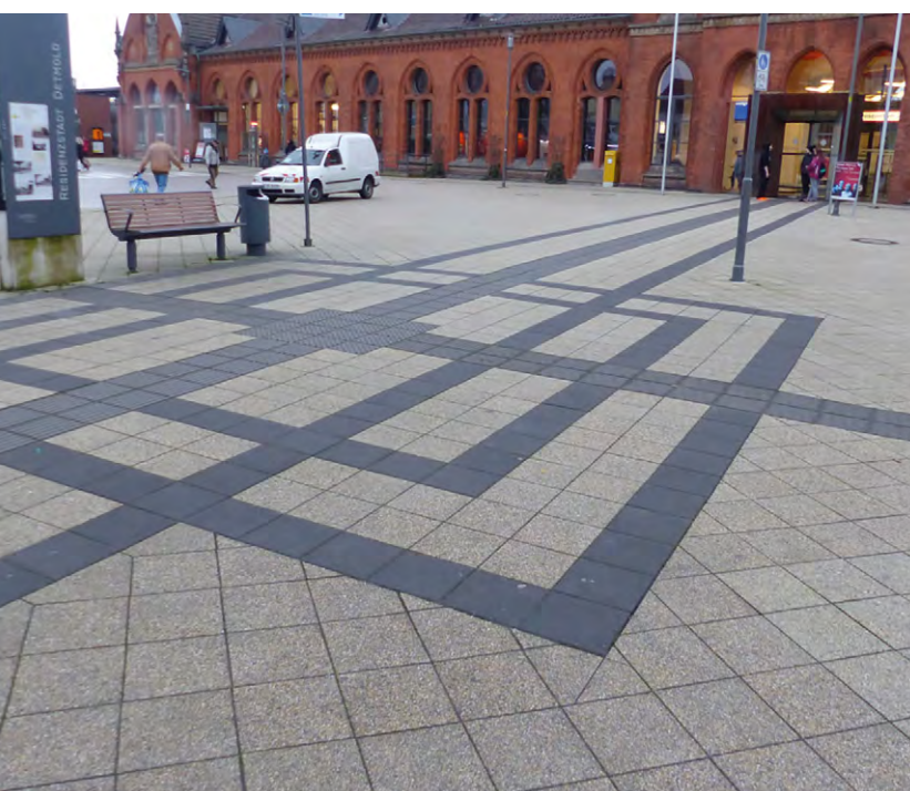
Betonsteine mit TiO 2 -Beimischung (Bahnhofvorplatz Detmold).
