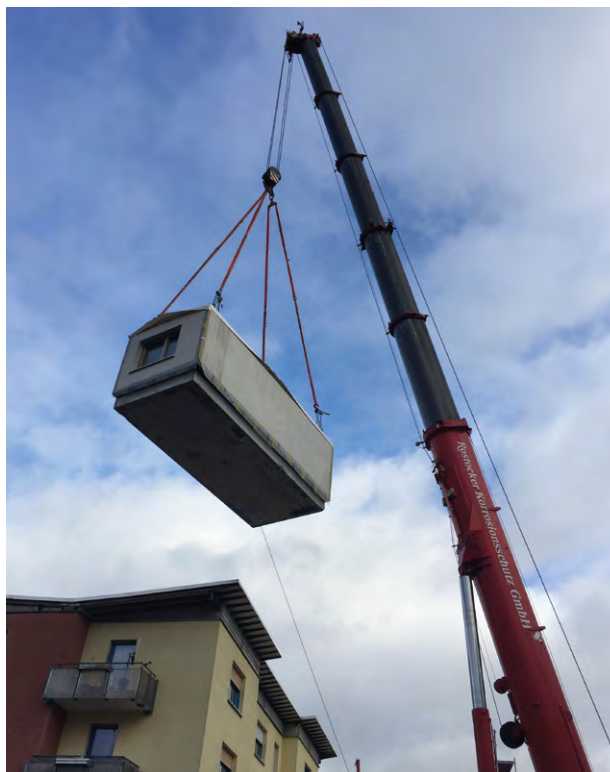
Die vorgefertigten Module wurden nach dem „Lego-Prinzip“ aufeinander gestapelt und miteinander verbunden.
