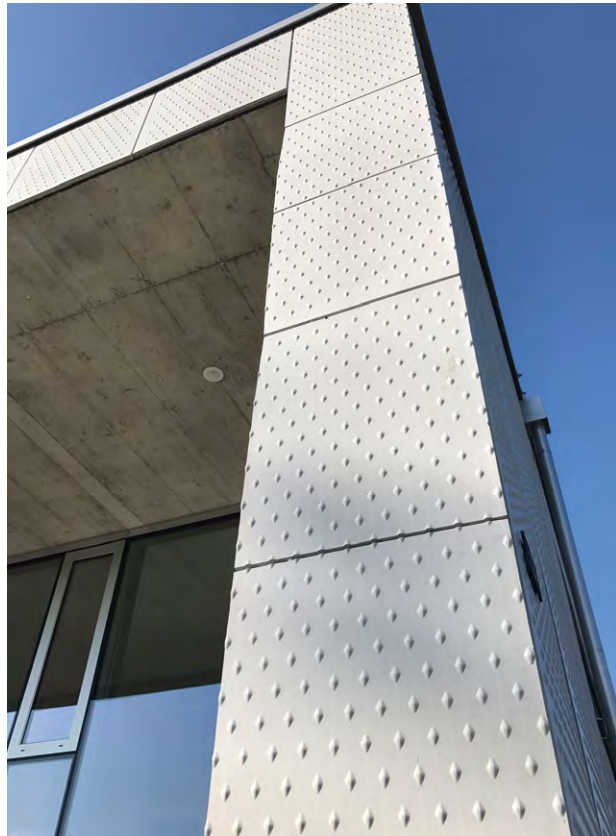
Die Fassade des Neubaus wurde mithilfe von Strukturmatrizen in Carbon bewehrtem Beton gestaltet.
