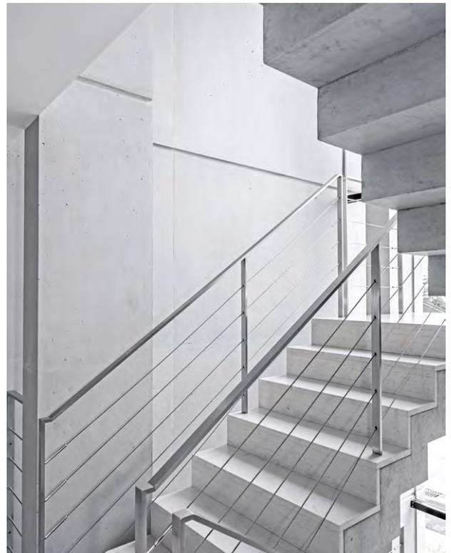
Fertigteiltreppe mit Belag aus Betonwerkstein.
