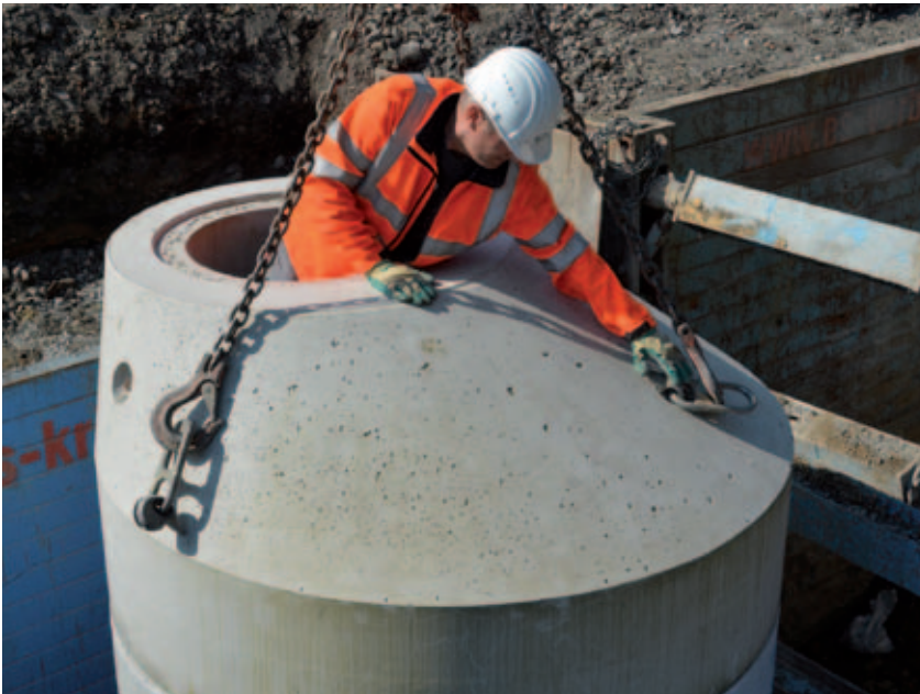
Die Montage eines Schachtes erfolgt in mehreren Arbeitsschritten, hier: Abschließende Montage des Konus.
