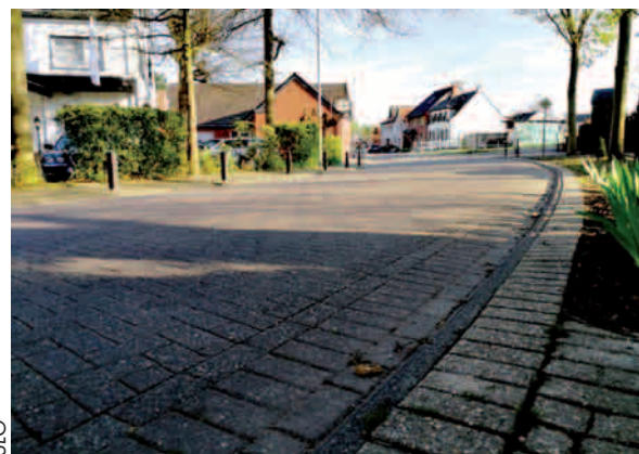
Ortsdurchfahrt Wassenberg bei Heinsberg in Betonpflaster: Auch nach mehr als drei Jahrzehnten noch in tadellosem Zustand.
