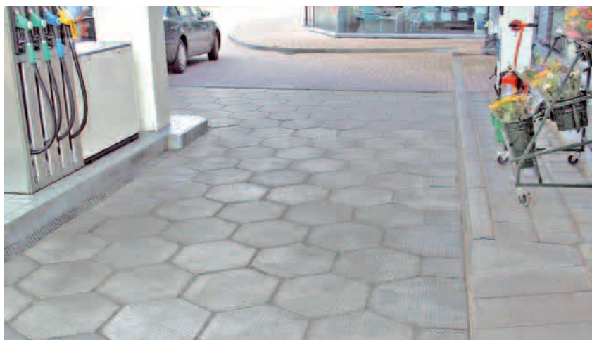
Für flüssigkeitsdichte Tankstellenbeläge können auch zukünftig Beton-Wabenelemente mit Schlüsselweite ab 500 mm eingesetzt werden.
