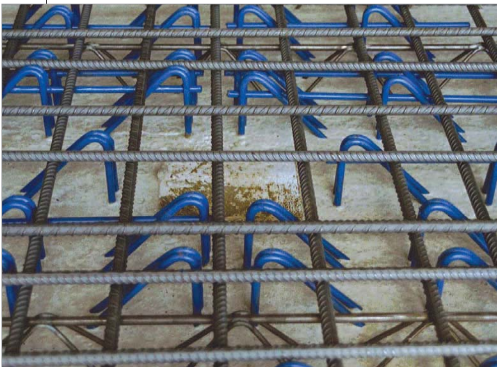
Bild 5: Obere Biegezugbewehrung auf den Obergurten der Filigran-Durchstanzbewehrung
