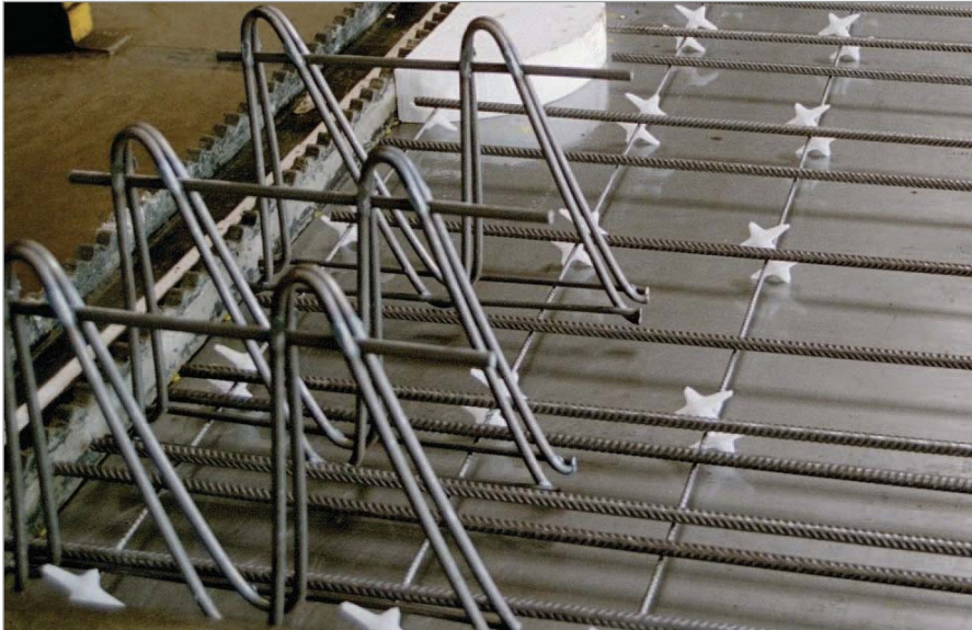
Bild 10: Die Filigran-Durchstanzbewehrung wird auf die Querstäbe gestellt
