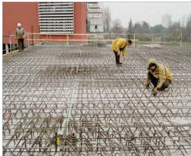
Bild 16: Verlegung der unteren Bewehrung auf der Baustelle
