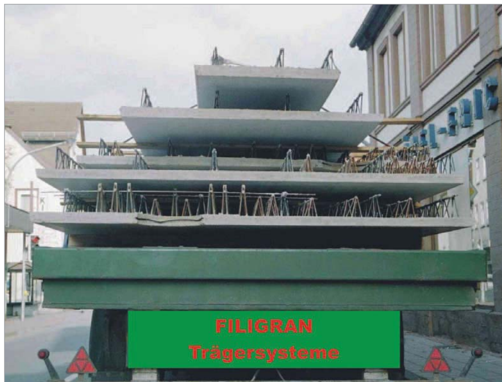
Bild 13: Transport von Elementdecken
