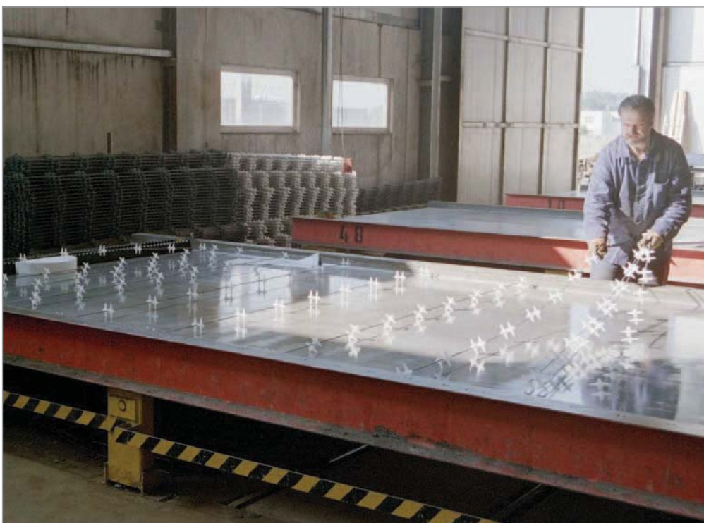
Bild 9: Einbau der Querbewehrung in Elementplatten
