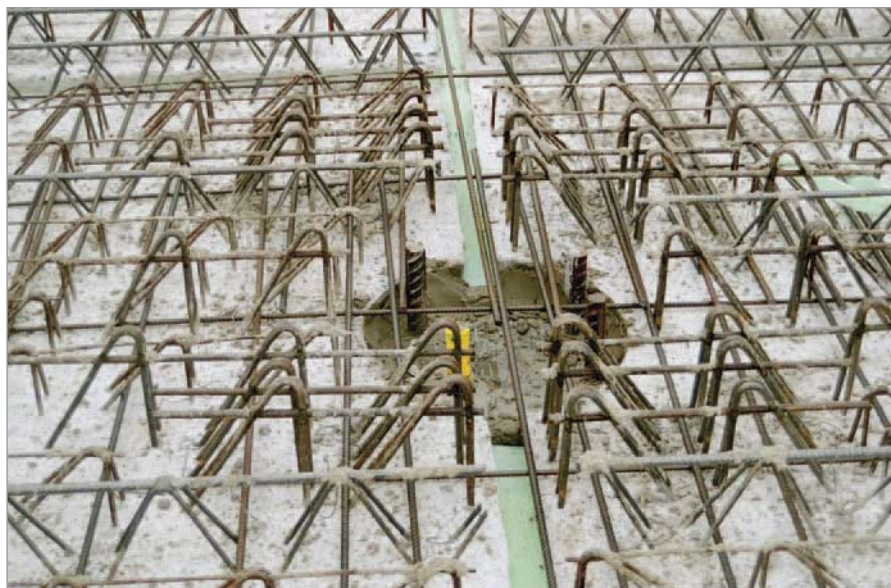
Bild 17: Stützenbereich mit Filigran-Durchstanzbewehrung
