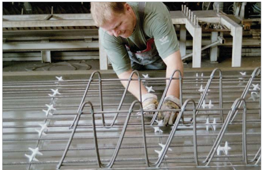
Bild 11: Einbau von hohen und langen Elementen
